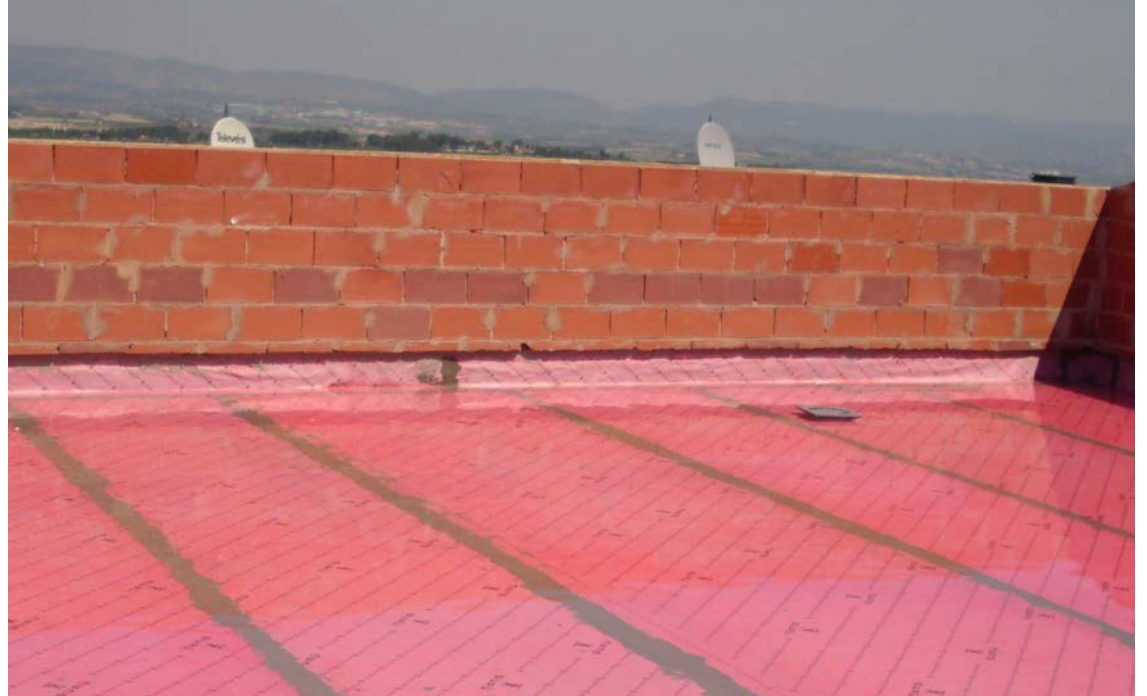
Prueba de inundación en una terraza impermeabilizada con WATER-STOP
