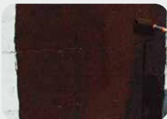
Aplicar una primera capa de CAUFIX diluido en agua a partes iguales, como imprimación.
