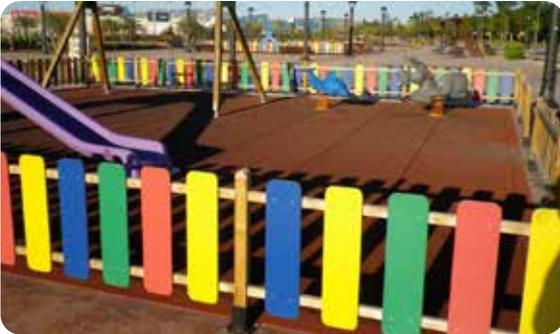
Nuestras losetas se componen de caucho reciclado a partir de ruedas de camión previamente trituradas y seleccionadas para su posterior uso, cerrando el círculo del neumático.
