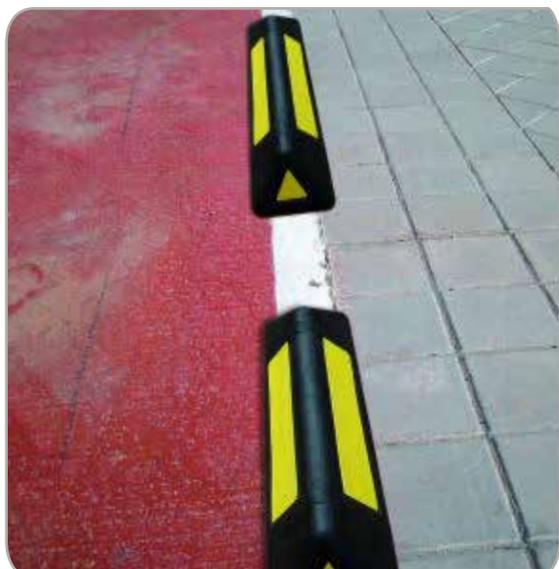
Delimitador de carril en caucho reciclado con bandas amarillas de caucho integradas en la pieza por vulcanización.
