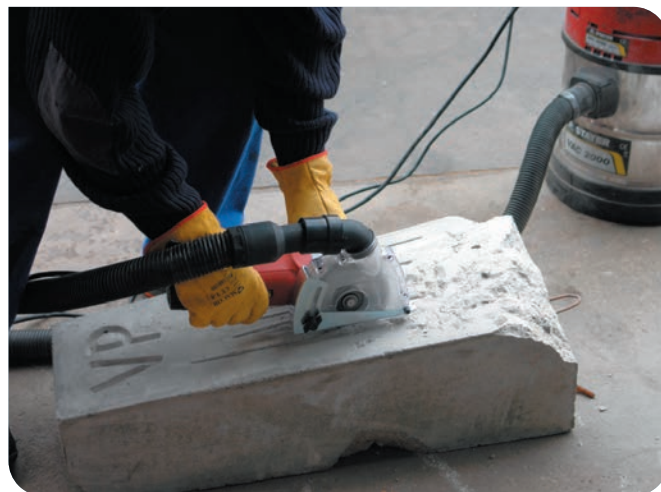
MINIAMOLADORA CORTANDO CON CÁRTER DE ASPIRACIÓN.
