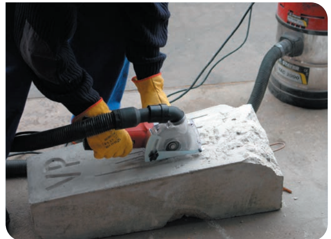
MINIAMOLADORA CORTANDO CON CÁRTER DE ASPIRACIÓN.
