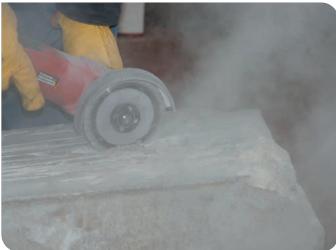
MINIAMOLADORA CORTANDO SIN CÁRTER DE ASPIRACIÓN.
