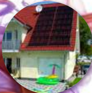
instalación en tejado
