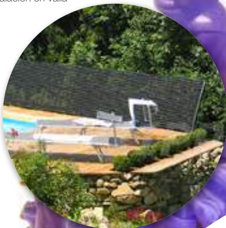
instalación en valla
