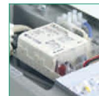
Dispositivo de protección SPD para preservar la luminaria de picos de tensión (6kV Basic, 10kV Advance y Premium).
