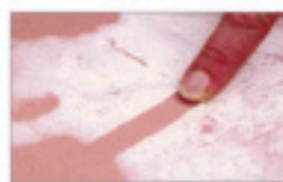
Efecto del depósito de cal en sustratos tratados
