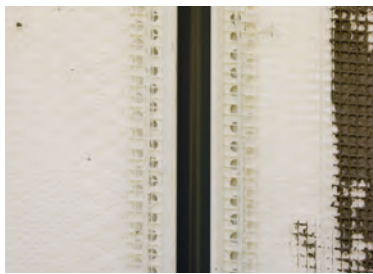
Junta del dilatacion
