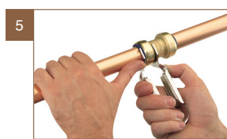
Apretar la herramienta de desmontaje hasta que se suelte el collarín.
