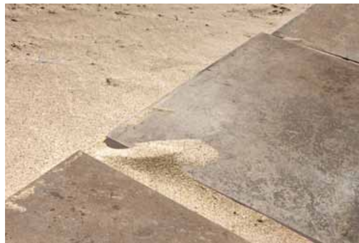
Posa su ghiaia o sabbia
